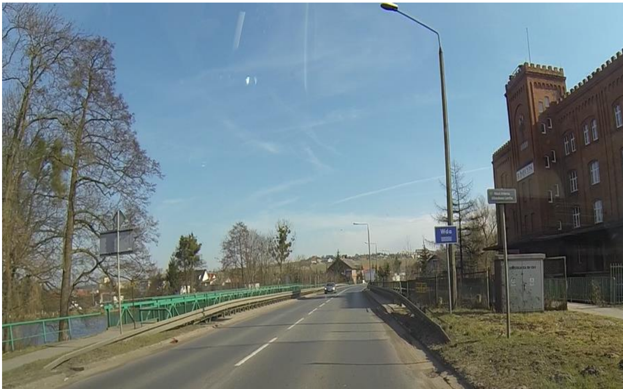
Fotografia 1. Widok na most na rzece Wda (źródło: materiały Inwestora, 04.04.2018 r.).
