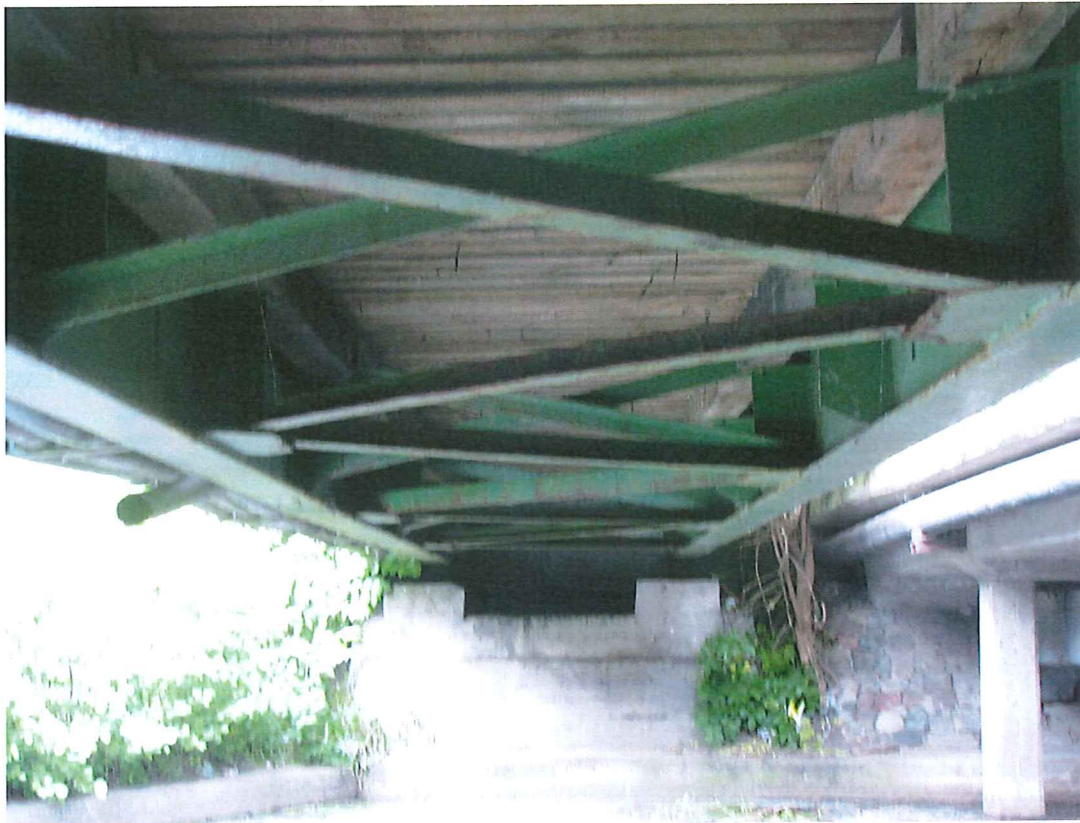
Fot. 5. - Widok spodu konstrukcji
