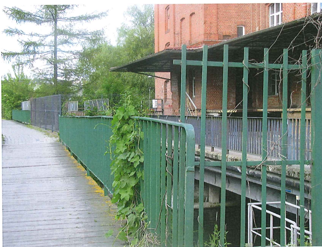
Fot. 4. – Linia balustrady po lewej stronie ciągu pieszego
