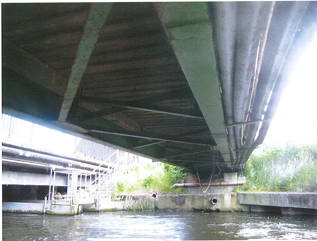
Fot. 5. - Widok spodu konstrukcji
